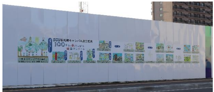
新札幌キャンパス工事現場仮囲い (札幌市厚別区)
